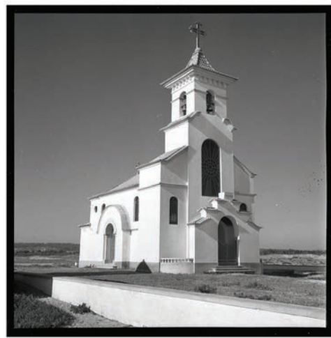
Capela de Nosso Senhor dos Aflitos e Senhora da Boa Viagem, praia de Esmoriz, 1956
